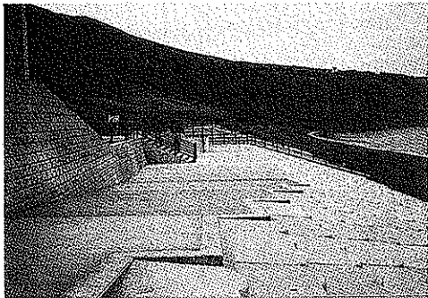
写真4. 98年春、完成したコンクリートの緩傾斜護岸
