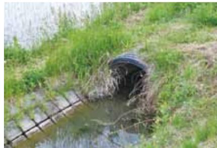
水路改修で、側面を斜めにすると、両生類、爬虫類、昆虫類、鳥類の生息にやさしい環境になる。トンネル化すると、地面を移動する生きものの水路への転落を防げる。
