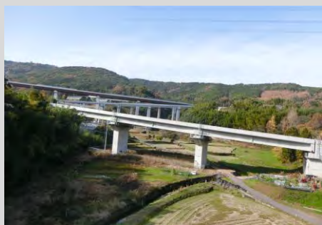
図 4-29：一般サイト「柿原の迫谷」で開通した高規格道路と残された小川（写真中央）。
