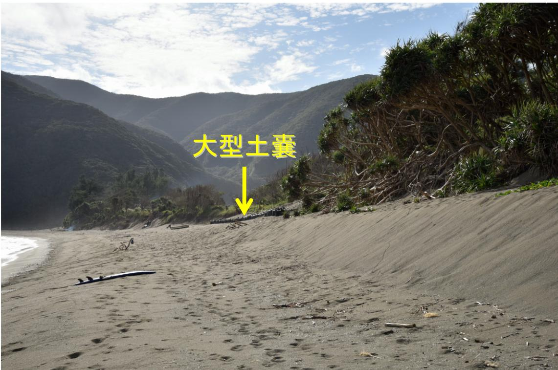
写真-6 嘉徳海岸北部での大型土嚢の設置とアダン林前面での応急的盛り土
