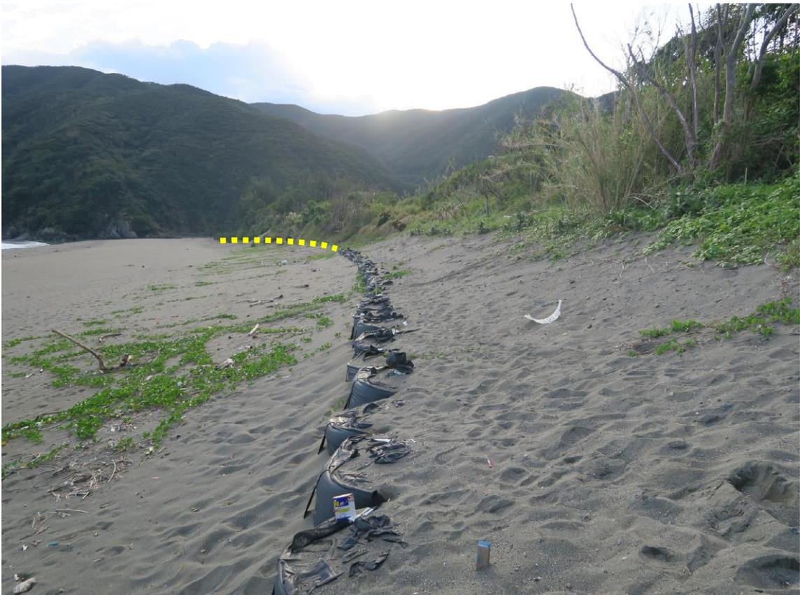
写真-16 地点3から南西方向を望む。大型土嚢の延長線上で著しい侵食が起きて倒木が起きているのが確認できる。
