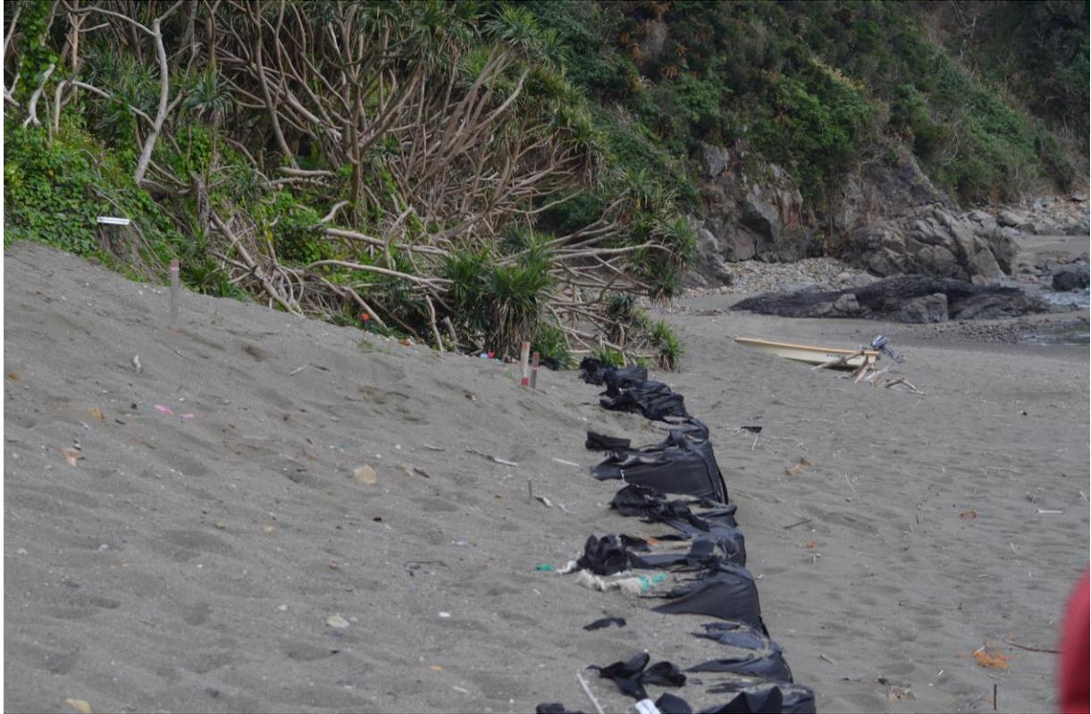
図 15 砂浜の砂が大規模に失われ、後背地の砂丘が浸食されてアダン林が流失している。土嚢で一時的な対策がなされている。
