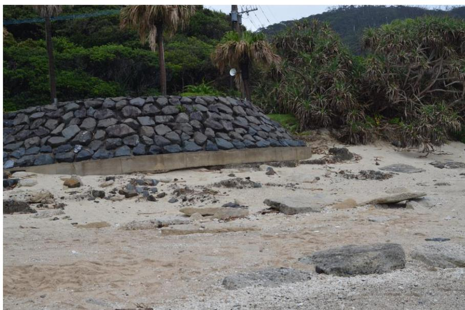
図18 砂が持ち去られて露わになった護岸の基礎部分
