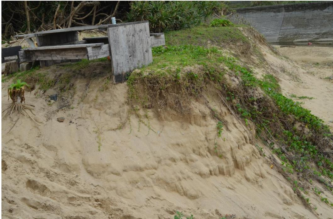
図 10 浸食により砂丘の上に作られたベンチが崩落している
