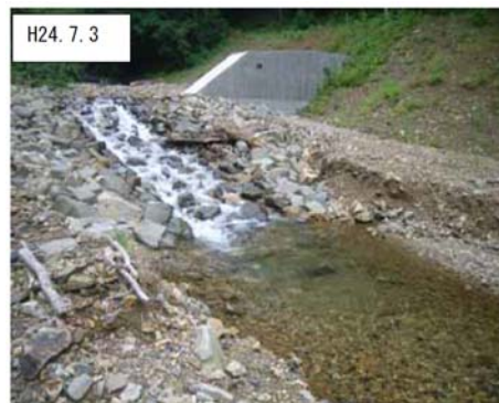
↑茂倉沢5-2号ダム（連続性を確保した床固め）
