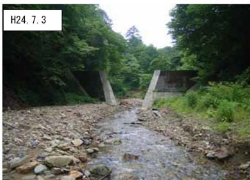
↑茂倉沢2号ダム（中央部を撤去したダム）
