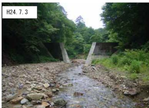
↑茂倉沢2号ダム（中央部を撤去したダム）
